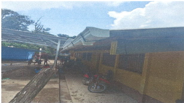
Foto 6: Instalación de canaletas y bajadas
