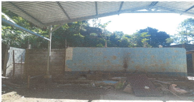
Foto 3: Mejoramiento de bodega de cocina
