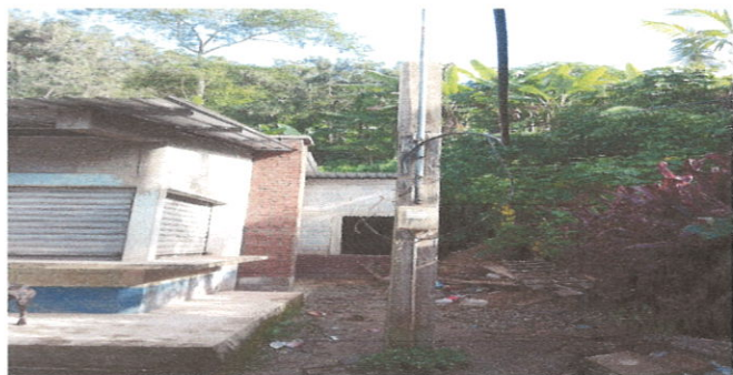
Foto 5: Instalación de chimenea con ladrillo
