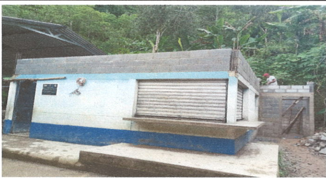
Foto 2: Mejoramiento de altura de cocina
